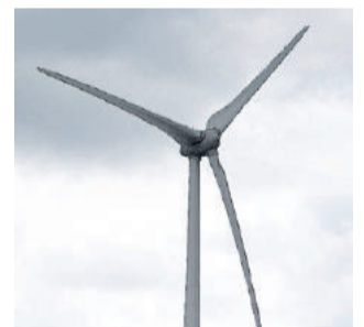
Op de uiteinden van de wieken zitten uilenveren die het geluid reduceren. (FOTO: DIK KUIPER)
