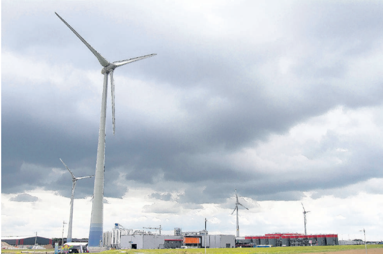
Je kan er niet omheen: op industrieterrein Zuiderzeehaven staan vier windmolens. (FOTO: DIK KUIPER)
