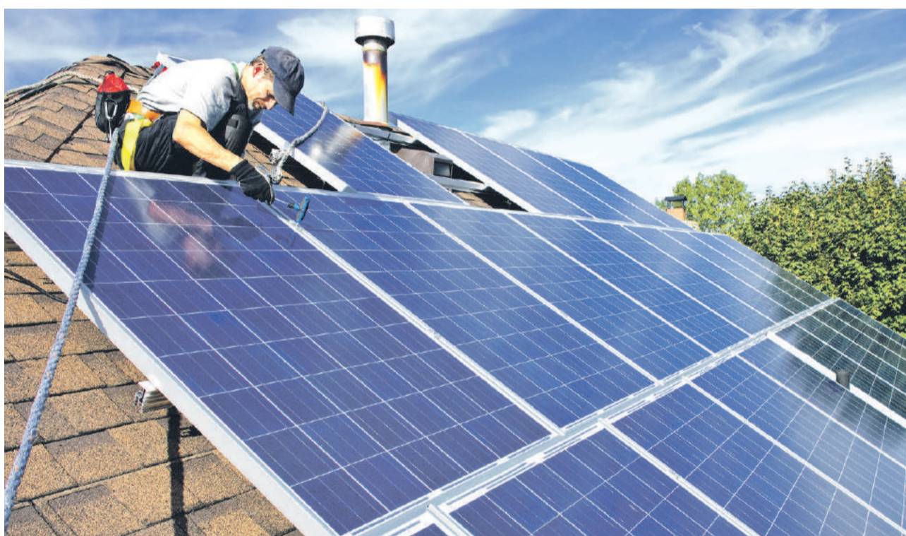
Het plaatsen van zonnepanelen op een dak.
