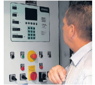
Alle technische componenten bevinden zich onderin de windturbine. (FOTO: TANJA SLAGTER)
