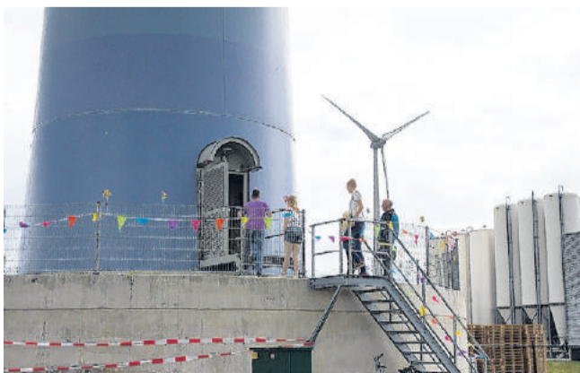
Bijzonder: de windmolens staan op een ruim vier meter hoge voet. Hiermee reikt de molen net wat hoger - en vangt daarmee meer wind - dan de windmolens die de basis onder de grond hebben. (FOTO: DIK KUIPER)
